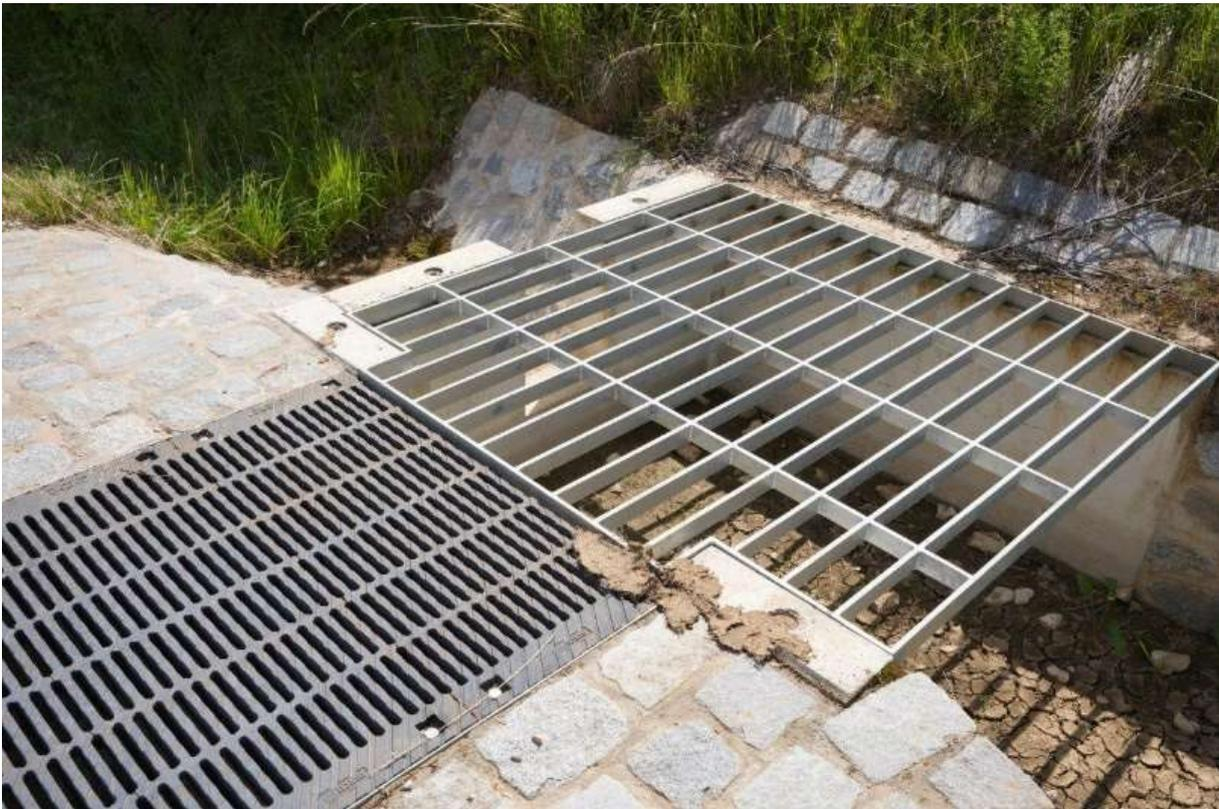
*Abbildung 2 Auffangbecken mit Betonfassung für Erosionsschutz/ Starkregenvorsorge in Enslingen*
